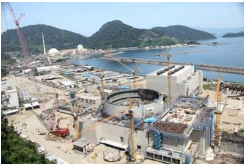
Visão geral da Usina Nuclear de Angra 3 em construção. Foto: Eletronuclear
