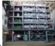
A instalação produz água desmineralizada para alimentar unidades de energia 1, 2, 3 e 4 de Rostov NPP (8 unidades de desmineralização, capacidade total de 9.600 m<sup>3</sup> / dia).
