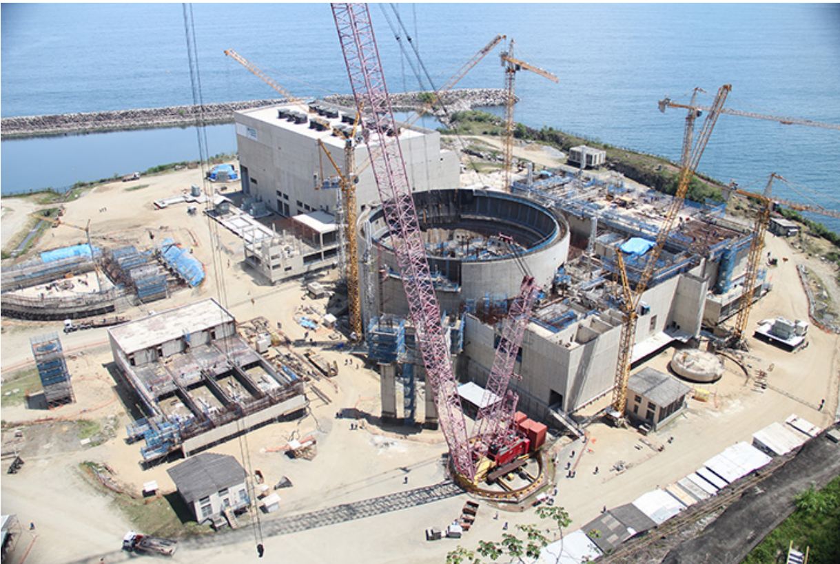
Canteiro de obras da usina nuclear de Angra 3 (foto de arquivo)
