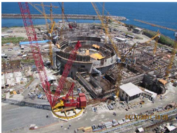
Angra 3 – status de construção (Nov 2011) do Edifício do Reator (foto Eletronuclear)
