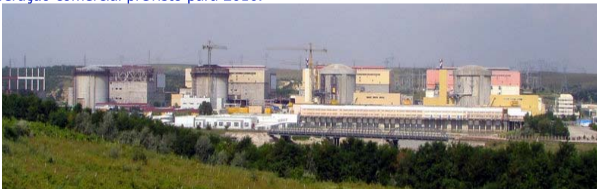
Central Nuclear de Cernavoda – Romênia – As unidades 1 e 2, à direita, estão em operação
