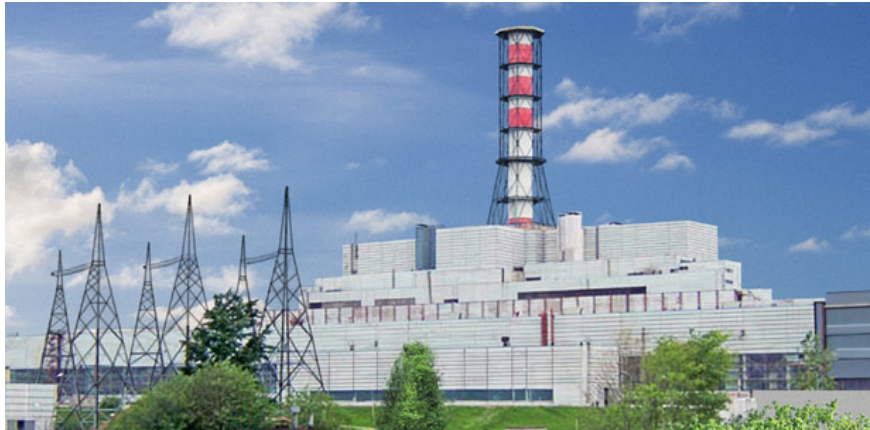
Central Nuclear Kursk composta de 5 reatores - tipo LWGR (1 em construção) foto: Atomenergoproekt
