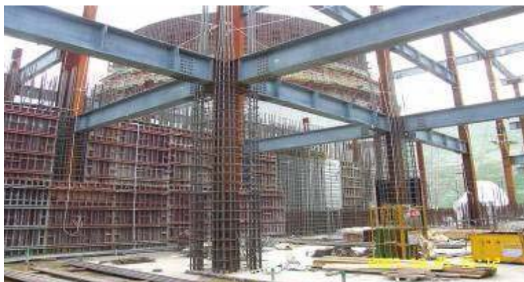
Estrutura de Construção em na usina Shin-Wolsong 1 – Foto AIEA
