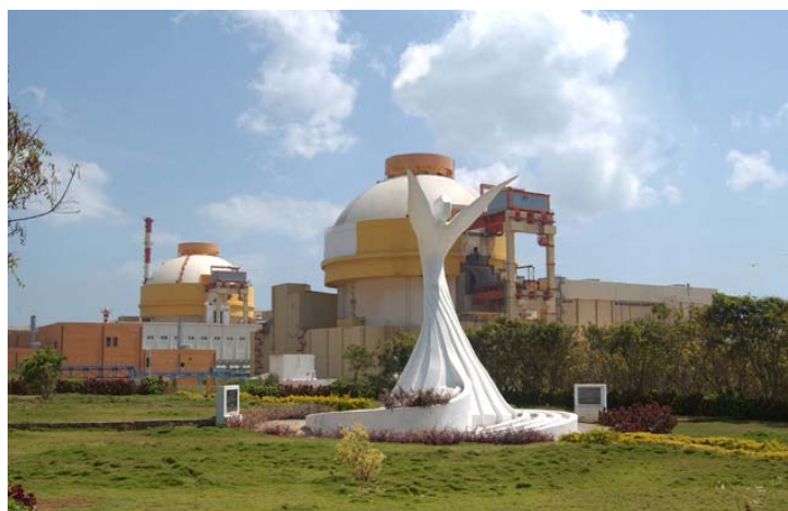
Dois reatores (950 MW -VVER) em construção em Kudankulam, Índia. (Foto: Atomstroyexport)
