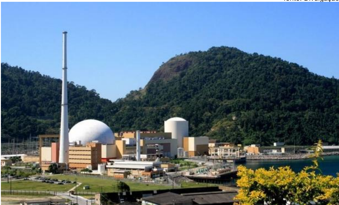
Na imagem, a usina nuclear de Angra 1, no Rio de Janeiro
