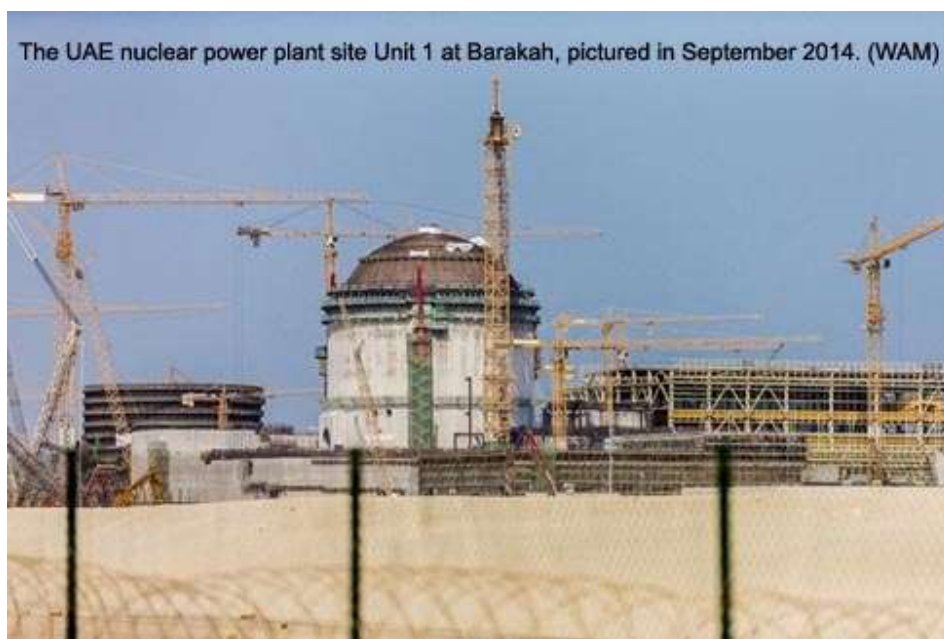
Sítio de Barakah – obras em andamento para as 4 unidades
