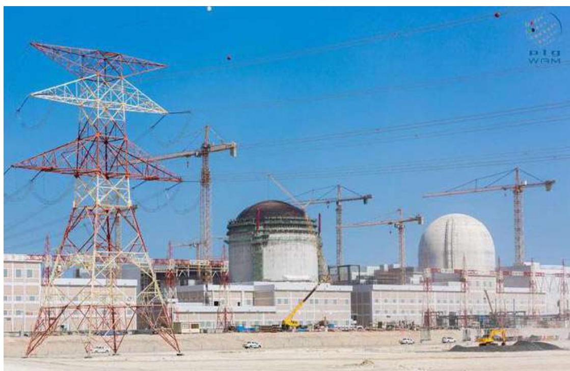
Construção no sítio da primeira central nuclear dos Emirados Árabes (Barakah-1 e 2 em destaque) na região oeste do país. Foto cortesia de Emirates Nuclear Energy Corporation
