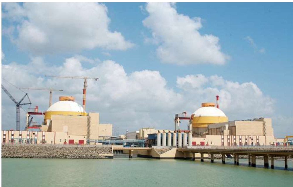
Kudankulam - Dois reatores (950 MW-VVER) na Índia. Reator 1 conectado à rede em outubro de 2013 (Foto: Atomstroyexport)
