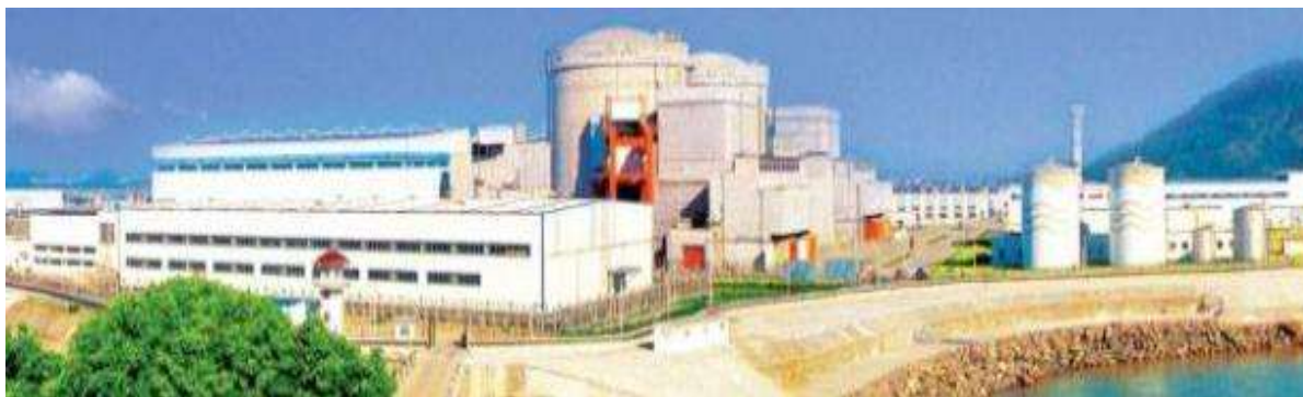
Usina Qinshan 4 Fase II em operação comercial desde 2012
