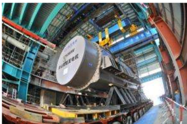
Taishan 1- EPR 1600 em construção
