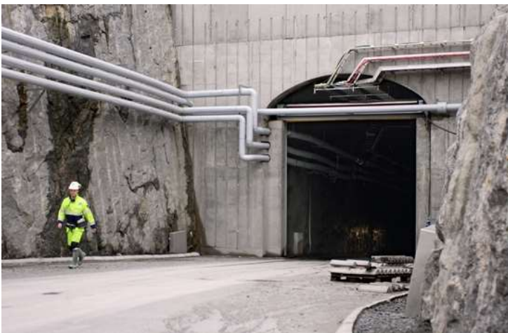
Finlândia: Acesso ao túnel que serpenteia gradualmente para baixo através da rocha a uma profundidade de mais de 420 metros. http://finland.fi/pt/vida-amp-sociedade/os-residuos-nucleares-descansarao-em-paz/
