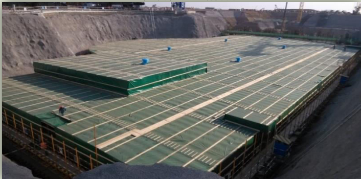
Dec 2014, protection shelter set up 2014年12月完成防护棚的搭设
