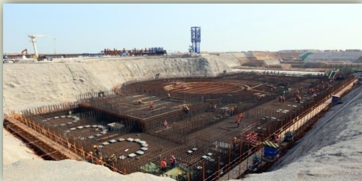
Sep 2014, reinforcement binding completed. 2014年9月完成钢筋绑扎
