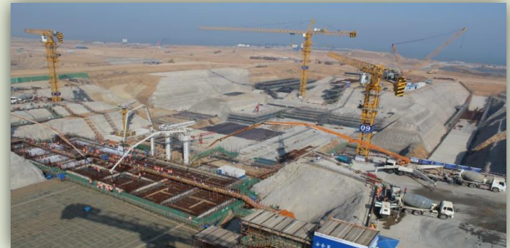
Apr 25-27 2015, 1 st concrete was poured 2015年4月25-27日, 第一跨基础混凝土浇筑顺利完成
