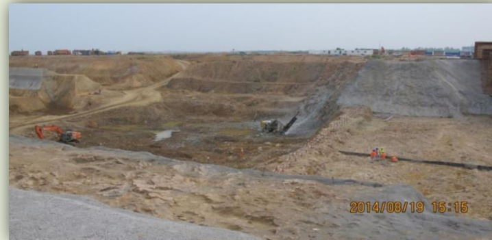
Aug 2014, excavation completed. 2014年8月, 完成负挖
