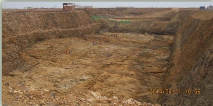
Apr 2014, NNSA inspected and accepted the foundation pit. 2014年4月国家核安全局验收了基坑
