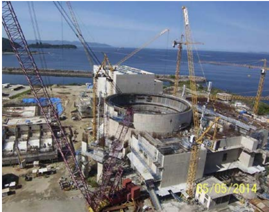
Fig. 25 - Obra de Angra 3
