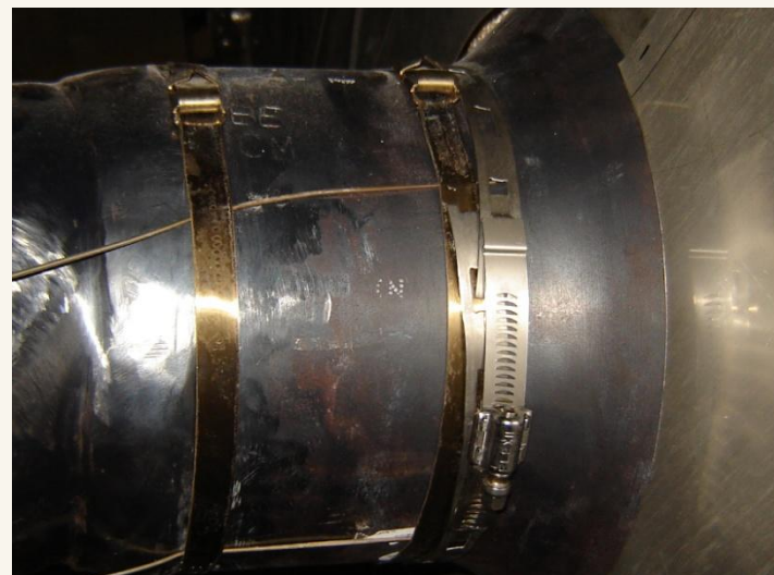
Controle de fadiga e extratificação térmica
