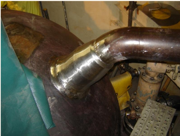
PZR – Sobrecamada de solda – Corrosão sob tensão
