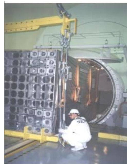
RACKS SUPERCOMPACTOS PARA ANGRA 2
